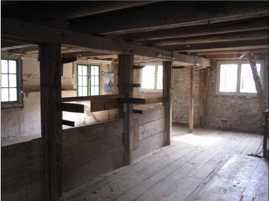
Afb. 23 De onderslag en standvinken onder de derde balklaag. Foto genomen voorafgaand aan de restauratie.
