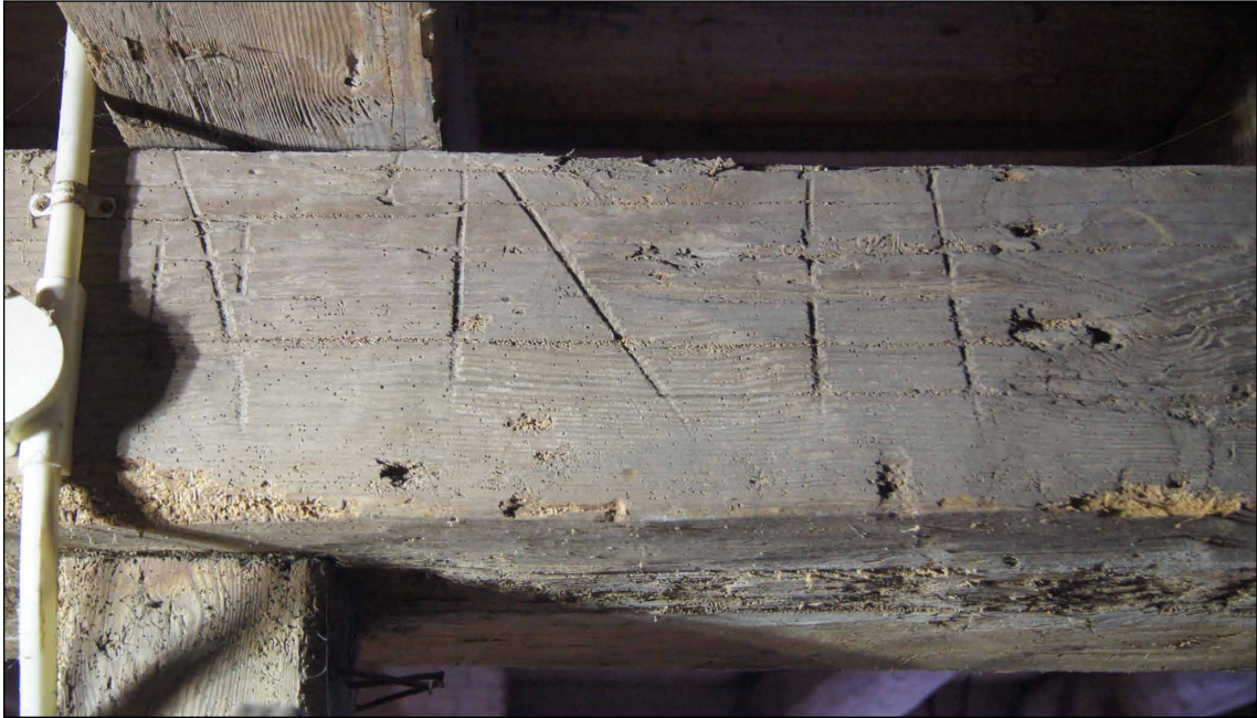
Afb. 31 Een merk op de onderslag van de derde balklaag.
