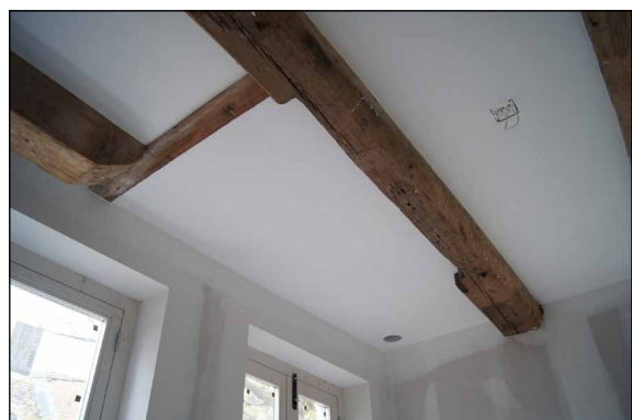
Afb. 33 Trapgat of hijsluik in de derde balklaag.
