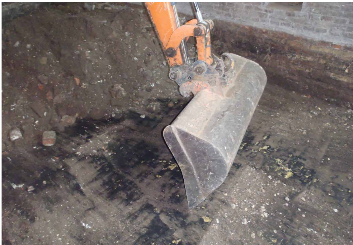
Afb. 42 De oorspronkelijke vloer van de begane grond komt onder de 20 ste -eeuwse ophoging tevoorschijn.
