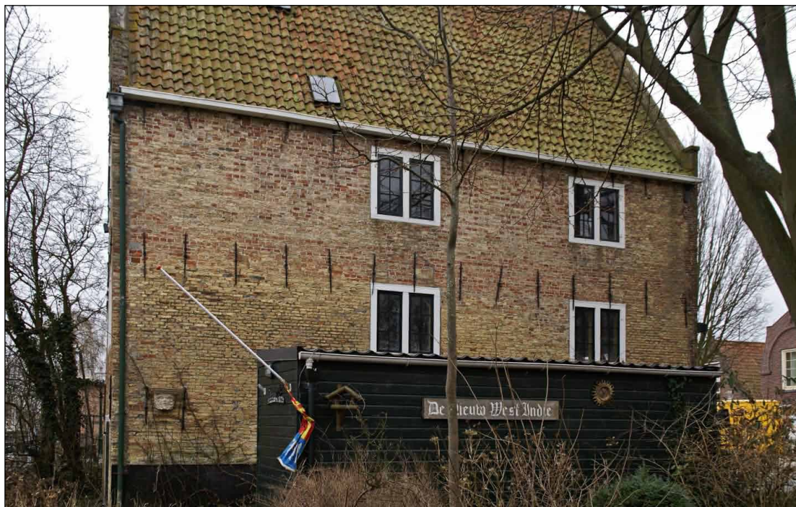
Afb. 19 De westelijke zijgevel. Foto genomen voorafgaand aan de restauratie door G. Vermeer.
