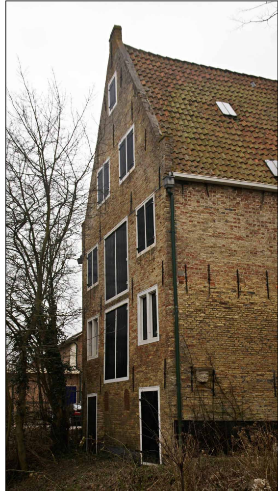
Afb. 17 De achtergevel aan de Oude Haven. Foto genomen voorafgaand aan de restauratie door G. Vermeer.
