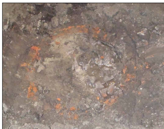
Afb. 50 De bovenzijde van een waterput van rode bakstenen.
