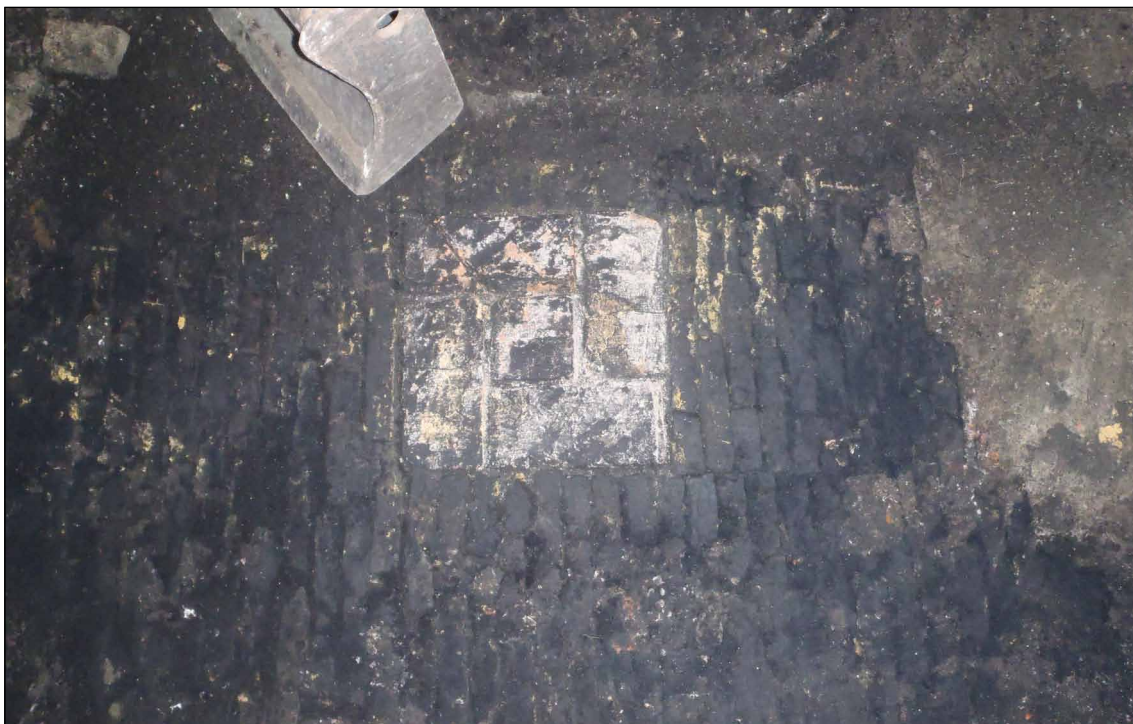
Afb. 44 Een van de poeren waar oorspronkelijk standvinken op stonden.
