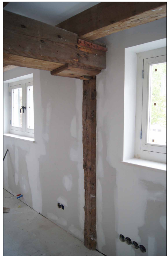
Afb. 24 De standvink tegen de voorgevel met duimen van een deur. Foto genomen tijdens de restauratie.
