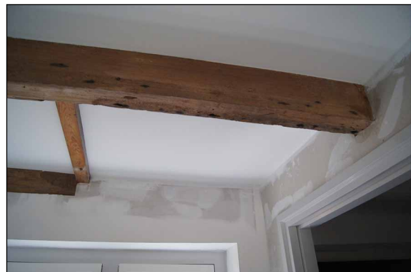
Afb. 32 Trapgat of hijsluik in de tweede balklaag.
