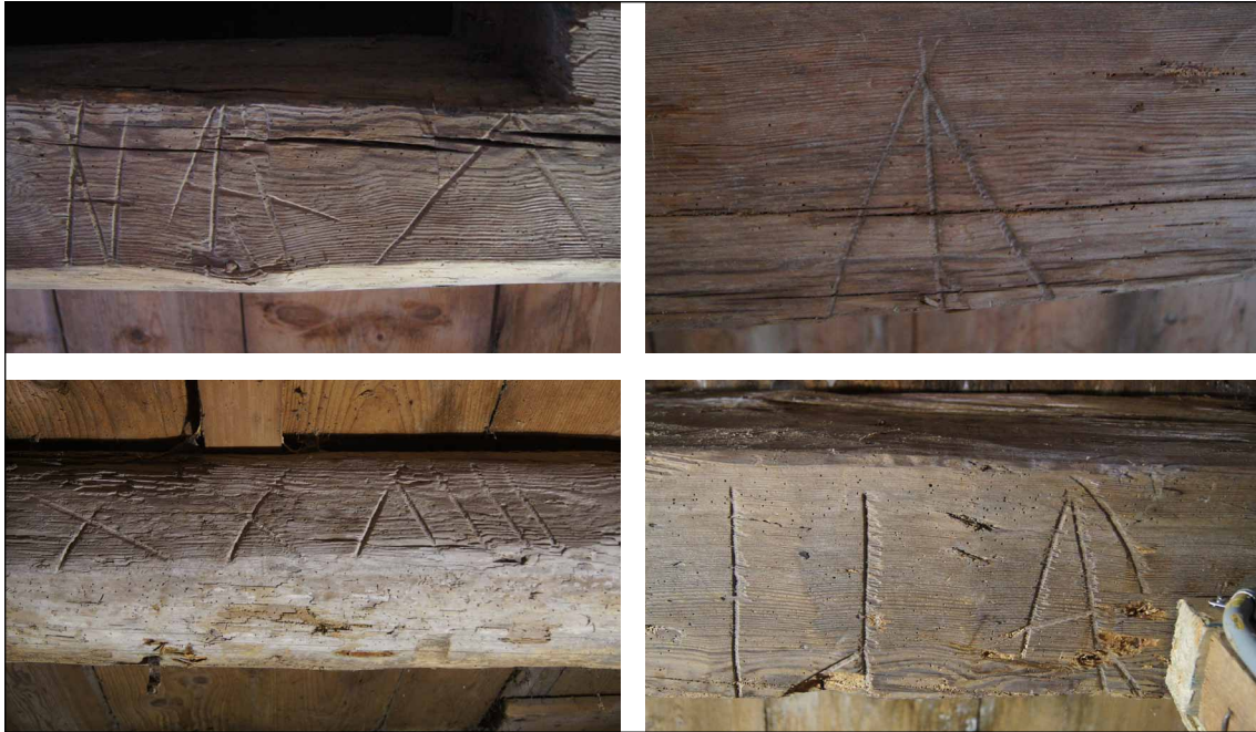
Afb. 28 Vier merken op balken van de derde balklaag.
