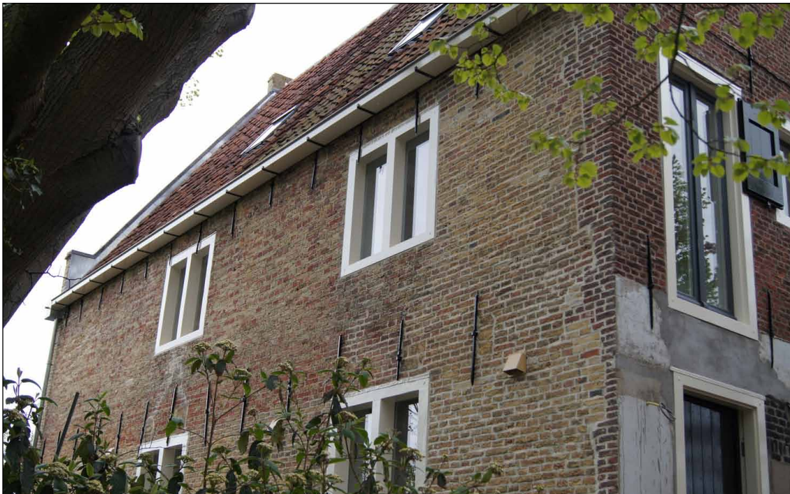
Afb. 15 De westelijke zijgevel met rechts de bouwnaad van de voorgevel. Foto genomen tijdens de restauratie.
