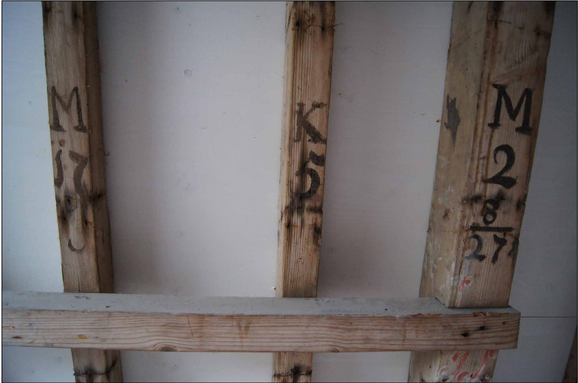
Afb. 36 Initialen en datum op spant en sporen van de kap.
