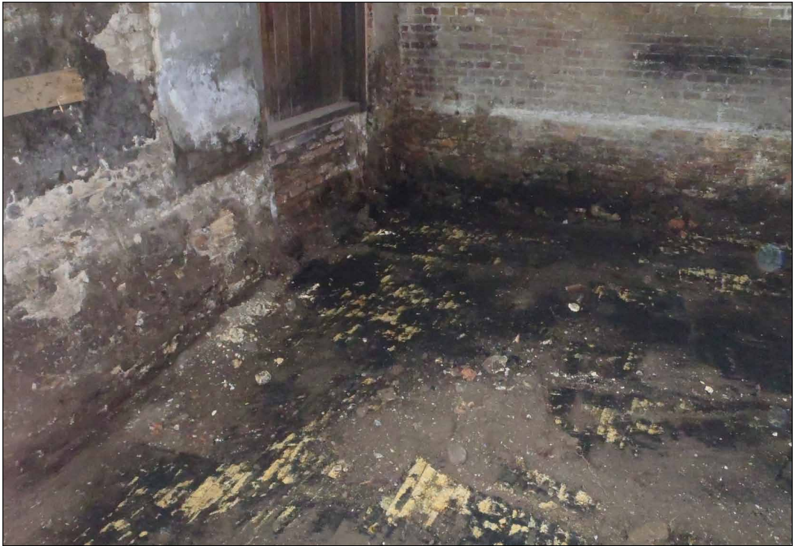
Afb. 43 De bakstenen vloer aan de achterzijde van het pakhuis. De vloer is zwart door de opslag van kolen. De onderdorpel van de deur in de hoek is in 1928 opgehoogd, tegelijk met de vloer van de begane grond.
