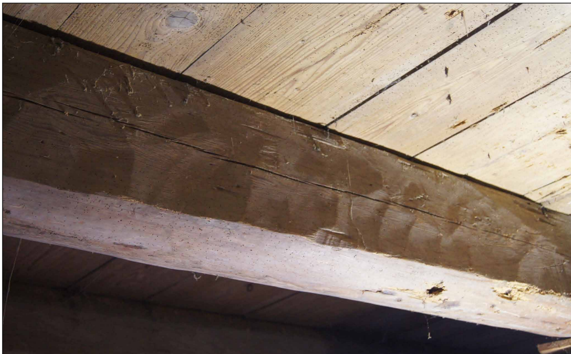
Afb. 25 Bewerkingssporen van een dissel op een gekantrechte zijde van een balk. Foto genomen tijdens de restauratie.
